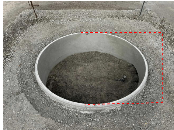
Abbildung 1: versetzter Betonring PIT AN-23 (Blickrichtung West)
