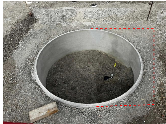
Abbildung 2: versetzter Betonring PIT AN-24 (Blickrichtung West)
